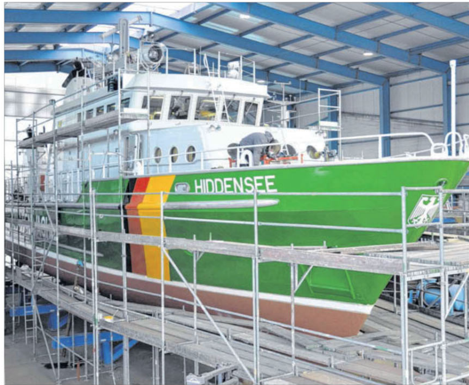
Blick in eine Reparaturhalle der Schiffswerft Barth.
